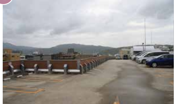
4 抜けのある屋上(北側)
