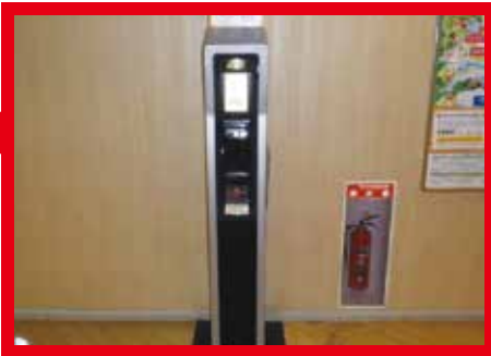
1F 駐車場緑ゾーン 南出口付近
